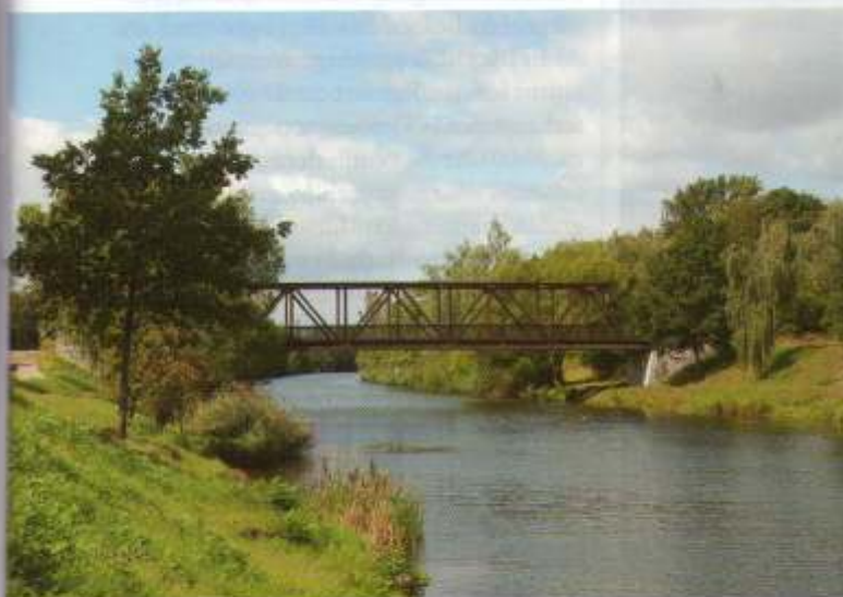
Die Ochsenwegbrücke mit 44 m Stützweite östlich von Dözig bei SEK-km 14,071 überquert den Kanal im Winkel von nahezu 90°
