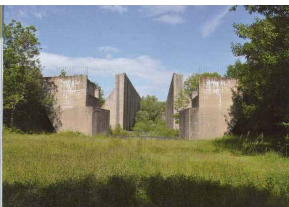
Auch die Ruine der Schleusentreppe Wüsteneutzsch (hier das Unterhaupt) wird nach und nach von der Natur in Beschlag genommen, ist aber weiterhin auch Besuchermagnet
